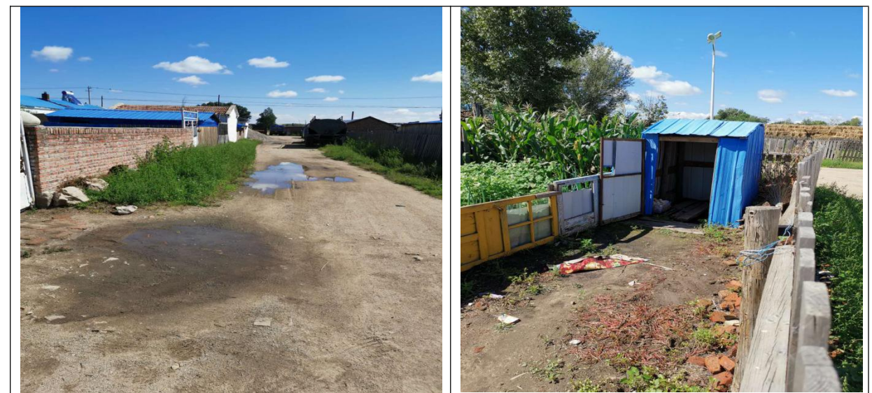
嵯岗镇嘎查街区及厕所现状
