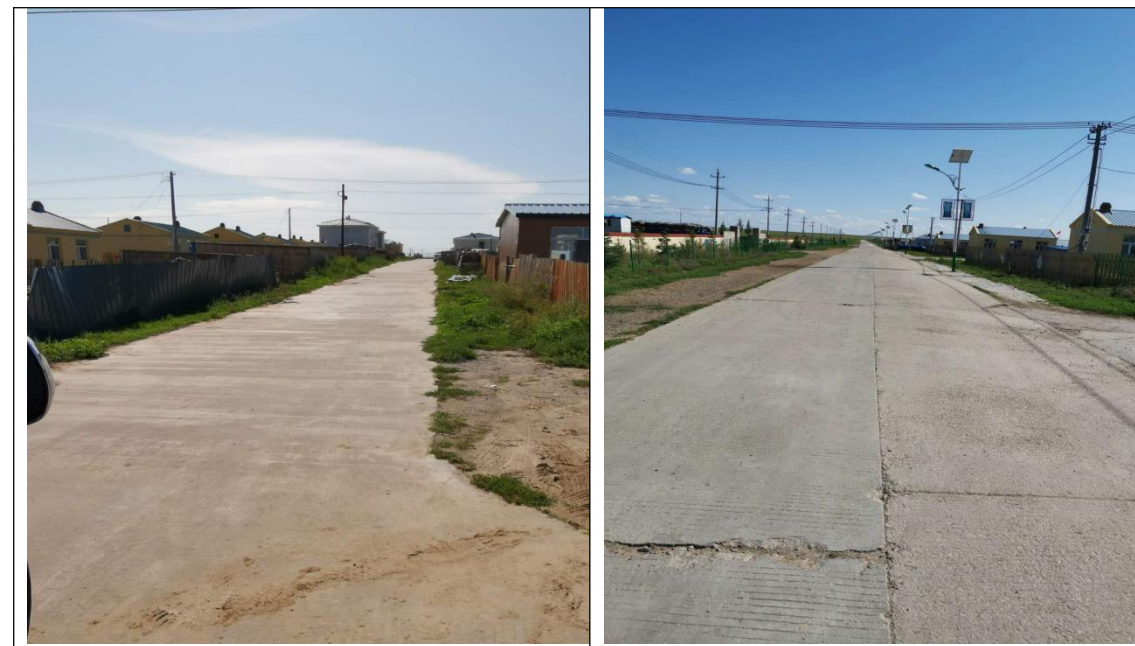
甘珠尔嘎查街区排水现状
