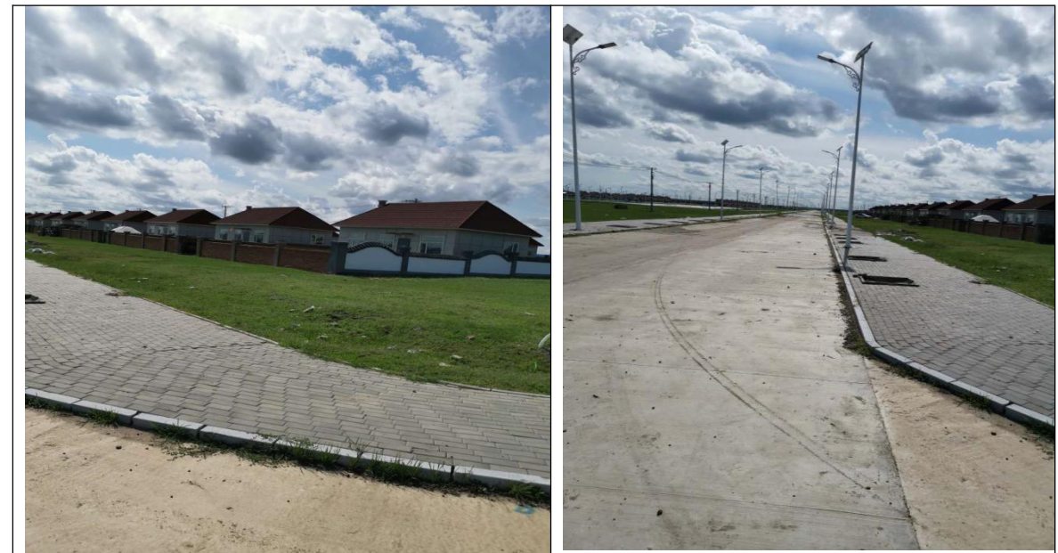
莫达木吉嘎查街区排水现状
