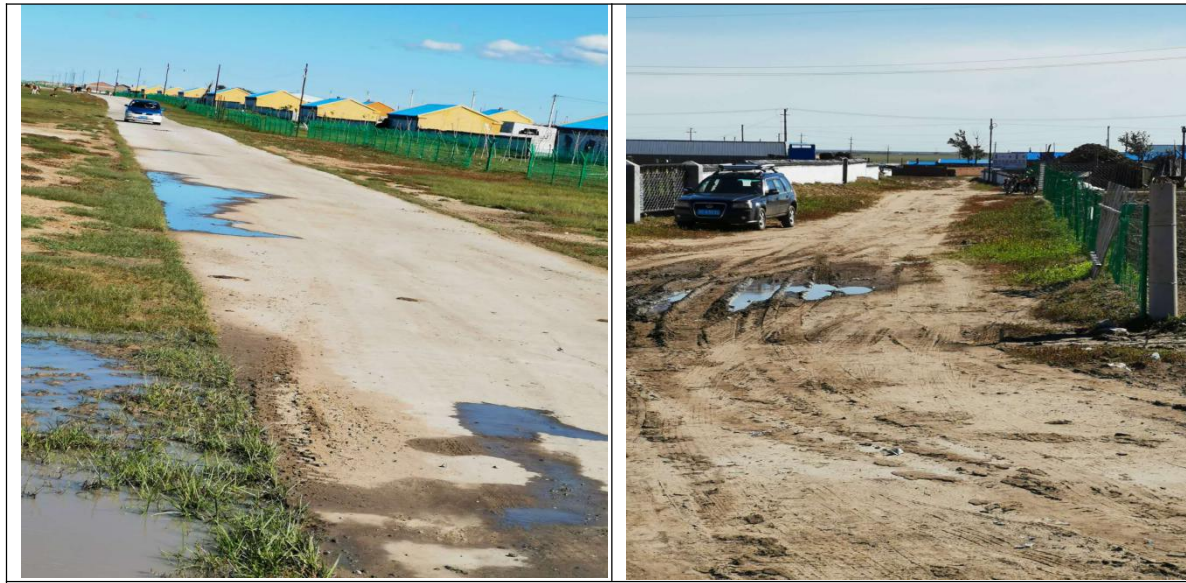
鸿图嘎查街区排水现状
